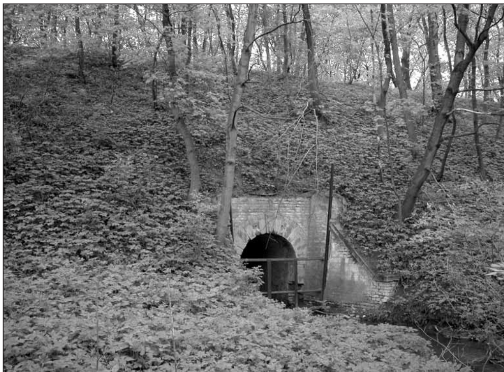
Násep přes údolí Šternberského potoka s propustí. Foto J. Likovský, 2004.
